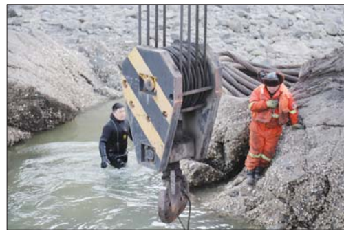
烟台打捞局潜水员分组轮流下水作业,穿引过底钢丝。
