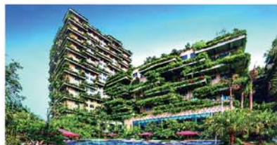
碧桂园集团总部大楼实景
