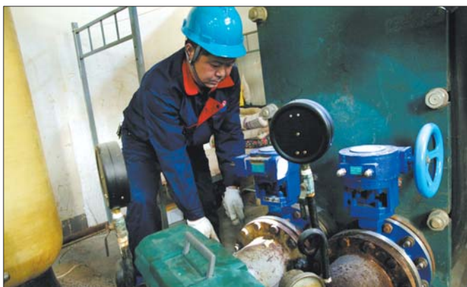
马军正在进行管网抢修。 本报记者 孟燕 摄
