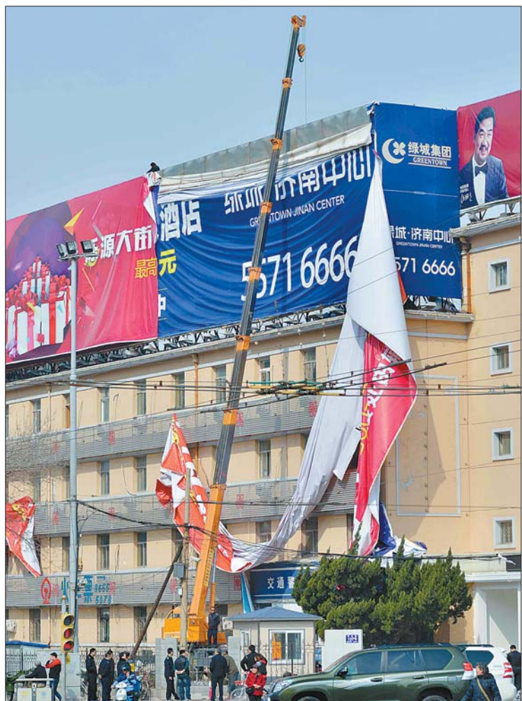
16日,执法部门动用吊车拆除楼顶大型广告牌。本报记者 陈文进 摄
