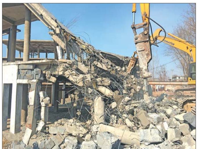
违建拆除现场。 本报记者 孙业文 摄
