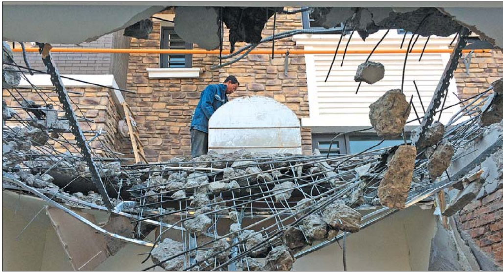
16日, 东方美郡一期, 工人已将车库拆出一个大窟窿。 本报记者 张阿凤 摄
