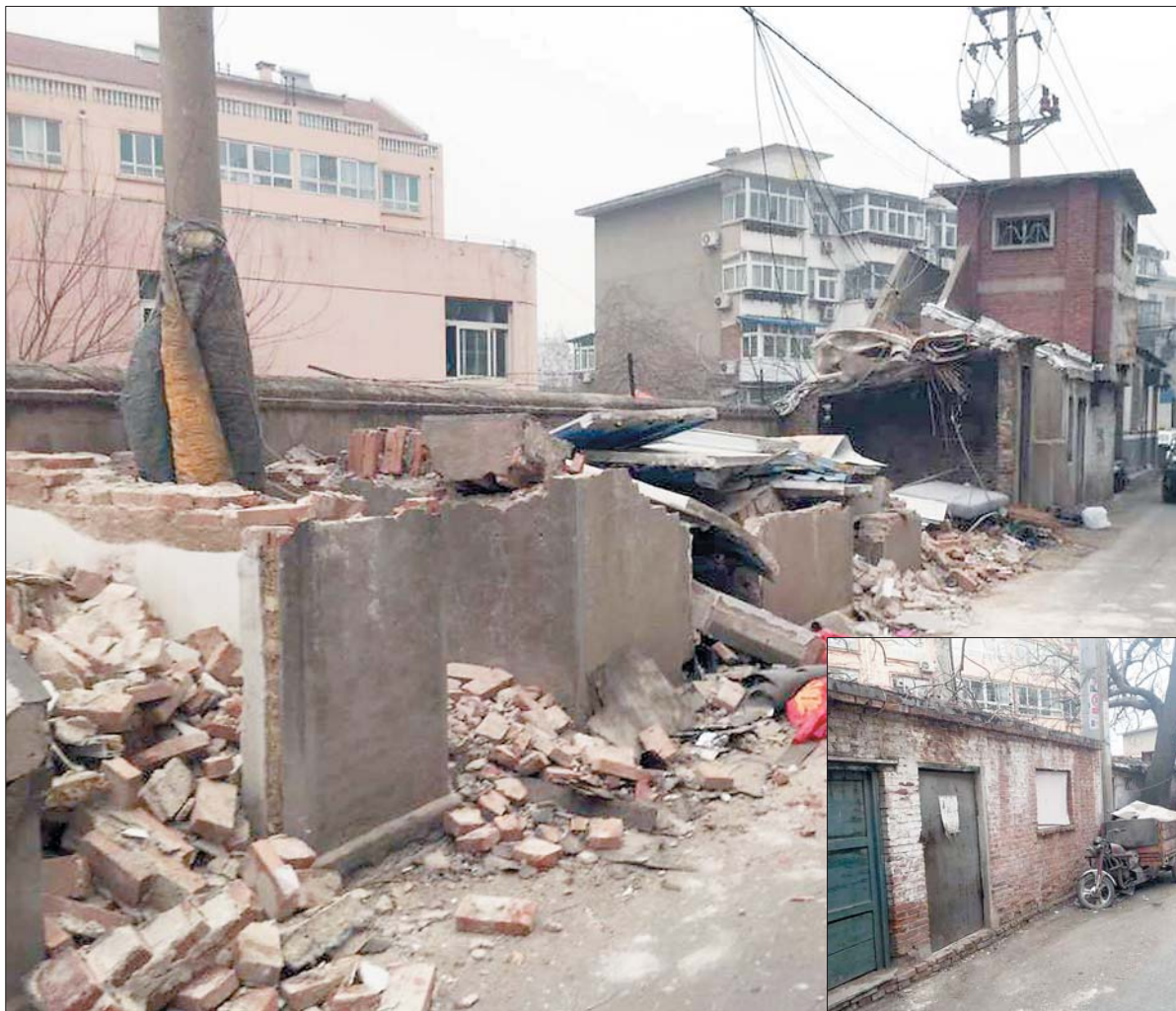
◀ 山大路 29 号 拆除违建。
