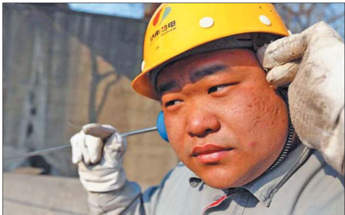
李运玺用听针检测漏点。
