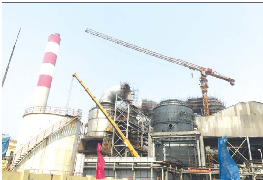
邹县电厂7号机组超低排放正在改造中。
