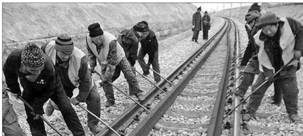
龙烟铁路上,施工人员正在铺轨。(资料片)
