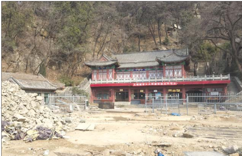
旧有建筑拆除重建, 打造新的游人中心。
