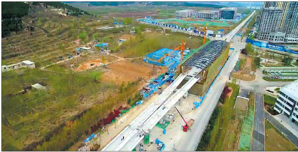
4月10日,济南R1线首座地铁站前大彦站主体完工。 本报记者 周青先 摄
