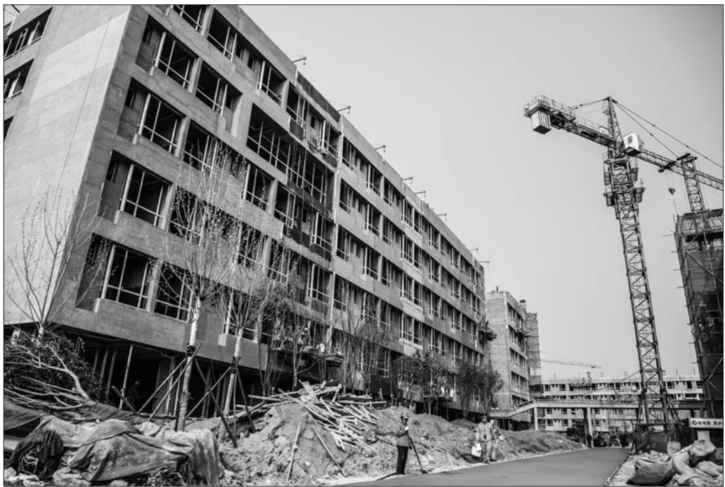
济宁海达行知学校主体已完工。本报通讯员 臧盛博 摄
