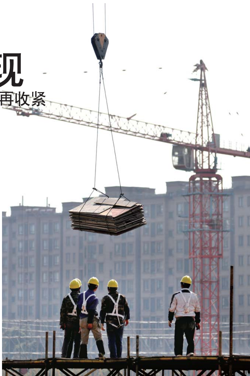
图为南京一处建筑工地。(资料片) 新华社发
