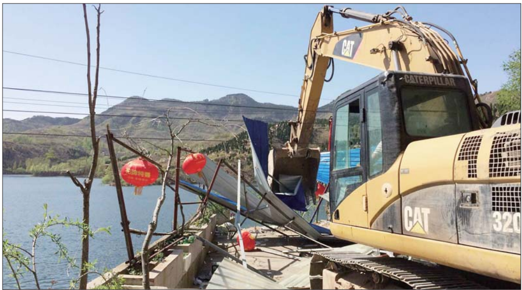
18日下午,柳埠街道组织人员、机械,拆除黄巢水库周边最后一家邻水农家乐。
