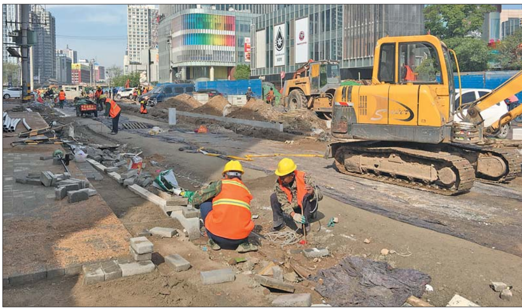
共青团路南侧已经开始铺设人行道。
