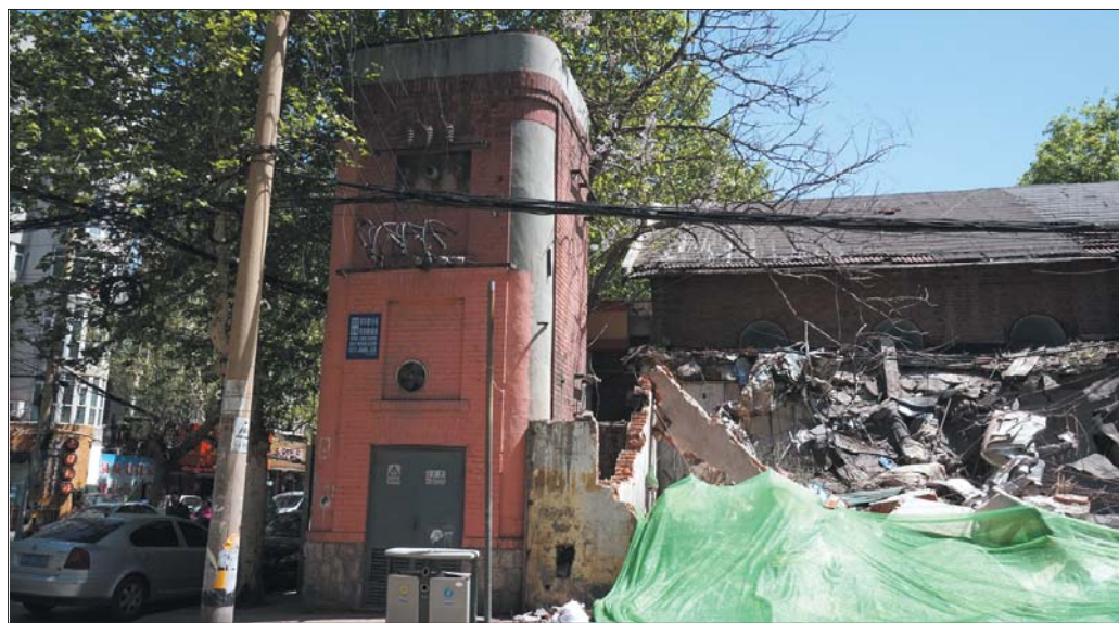
拆违拆临,让这处百年“电楼子”重见天日。
