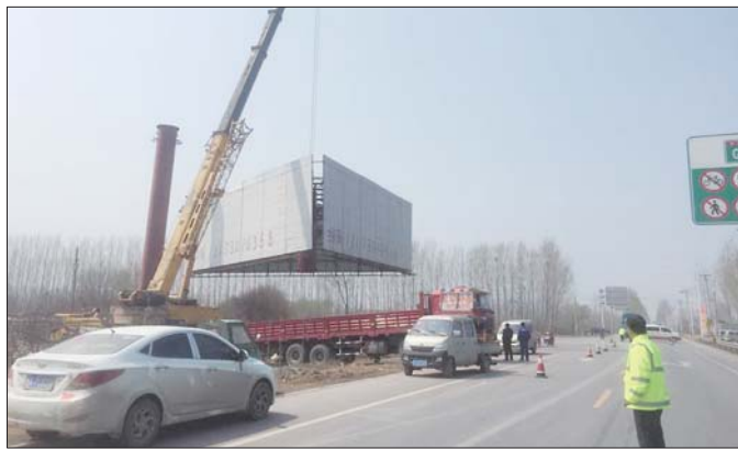
拆除道路两侧的大型违法广告牌。 济阳县公路局 供图
