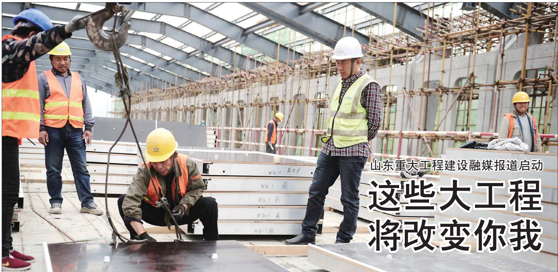
24日,“牢记总书记嘱托 奋力走在前列”——重大工程建设巡礼媒体采访活动启动,采访团来到济南地铁R1线前大彦站。目前,该站主体结构已经完工,“鱼肚子”式的外形渐渐露出。图为建设工人在吊装女儿墙的模板。 本报记者 戴伟 摄
