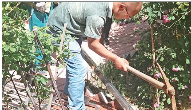
城管人员正在拆除小院篱笆。据了解,院内的植物有可能会得到保留。 本报记者 于悦 摄
