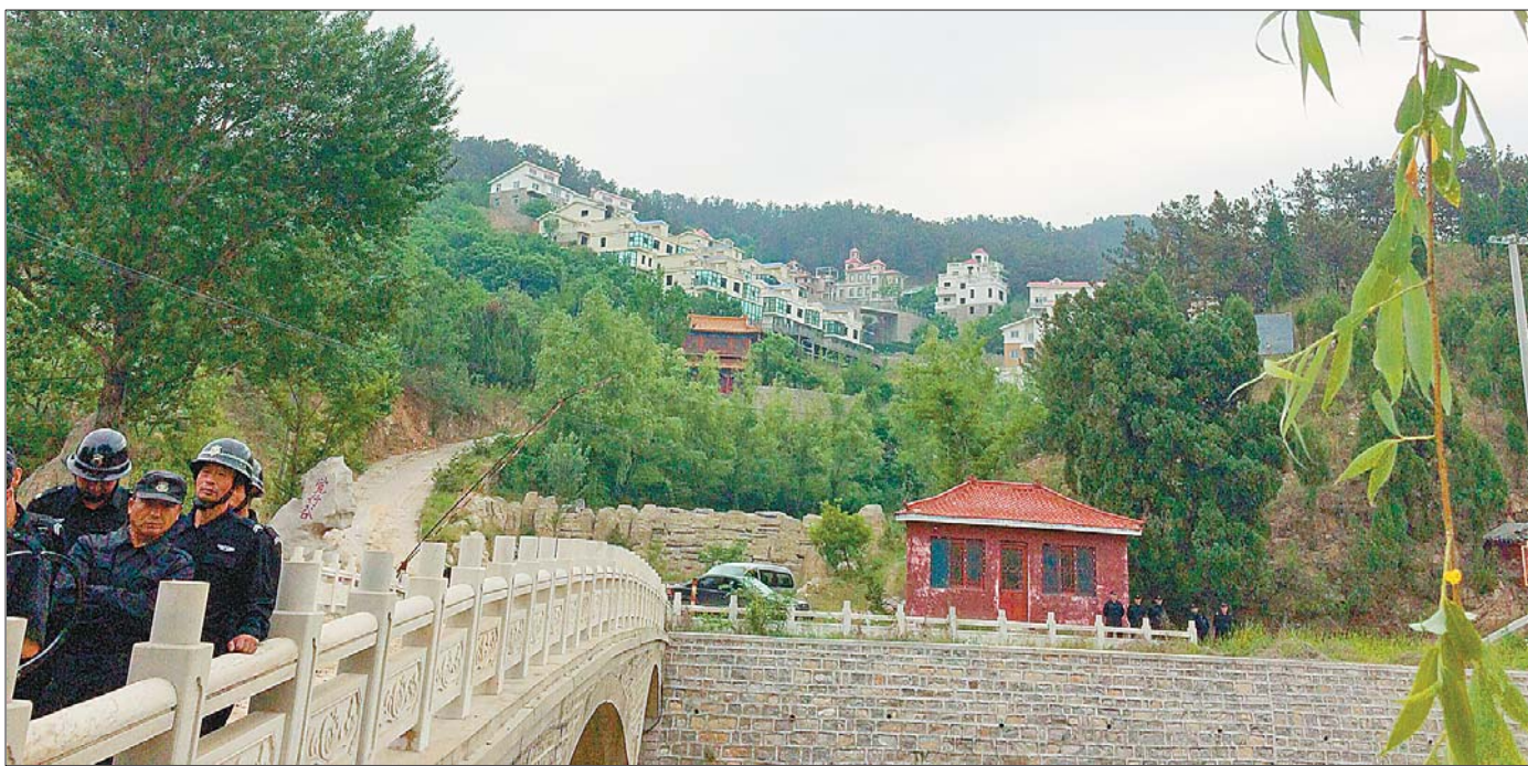
西营镇青龙峪违建别墅群,目前已拆除先期腾空的17栋。
