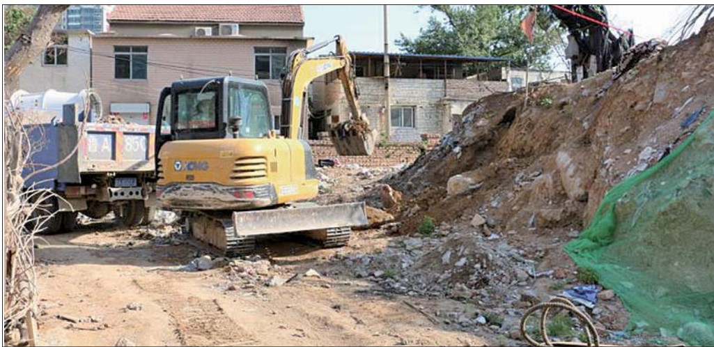
施工机械开始清理渣土山。本报记者 于悦 摄
