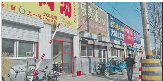
整治前:道路两侧墙皮脱落,商户牌匾大小颜色各异。
