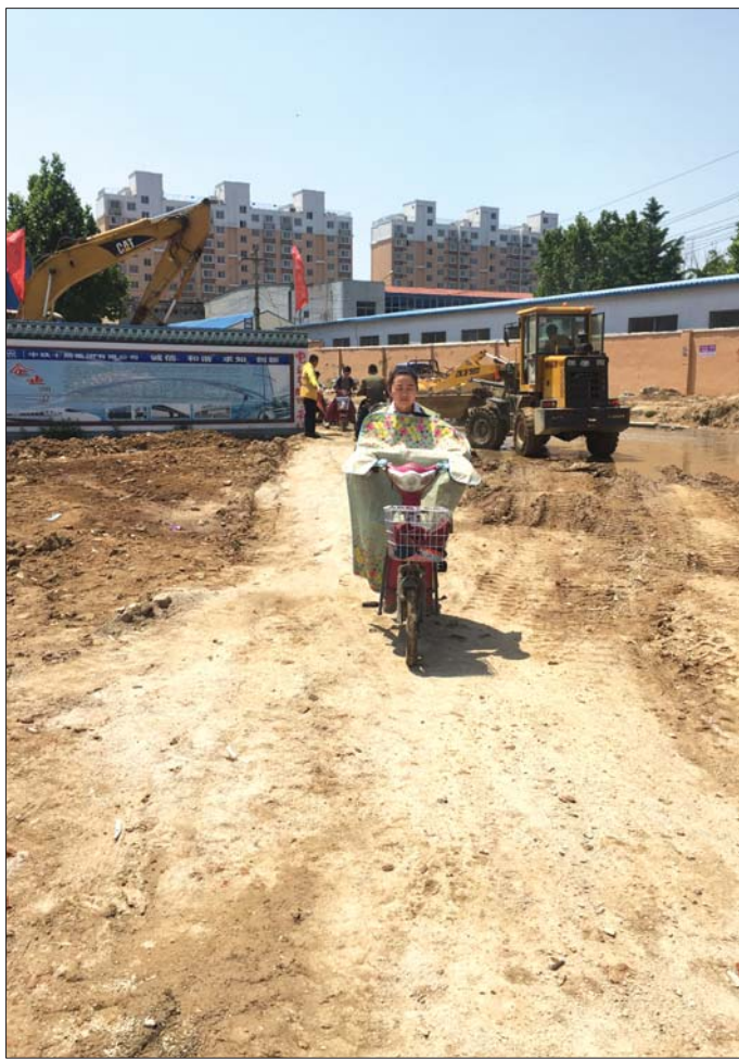
16日,居民通过临时抢修道路进出小区。
