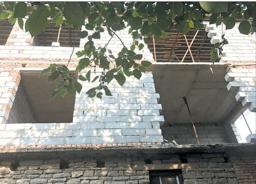
加盖工程过分简单，施工人员只是用立柱顶住加盖楼层。
