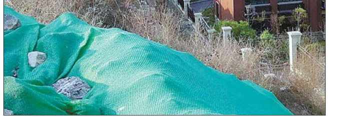
▲移除前, “渣土山”有 三 层楼高。
