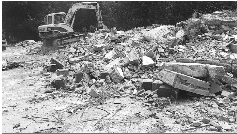
白云湖湖区最后一处违建被拆除。 本报记者 石剑芳 摄
