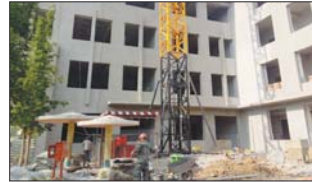
沂源县历山街道鲁山路小学新建工程进展顺利。(吴树平)
