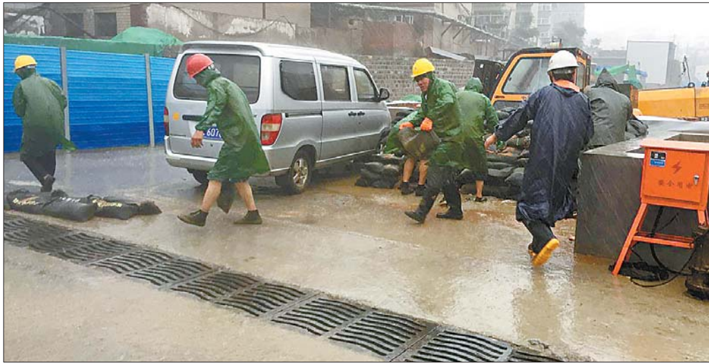
6日,顺河高架南延玉函地道施工段,施工人员正在堆放沙袋。 本报记者 王皇 摄
