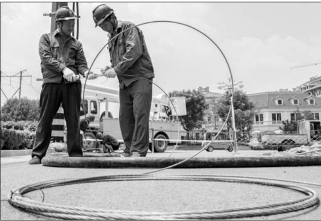
嘉祥供电施工人员检修线路。 本报通讯员 王者东 摄
