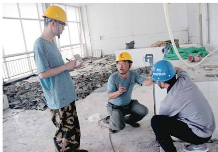
在一栋实施改造的楼里,几名建筑工人正在进行现场测量。
