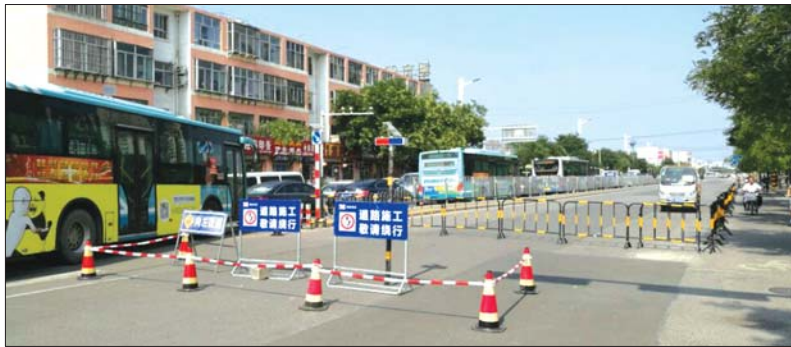
灵山大街东湖东路至迎春路段南半幅道路封闭施工。本报记者 路伟 摄
