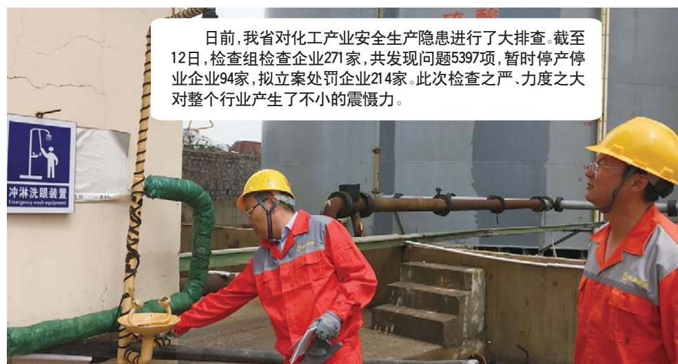
只是沿着出水口的管子流下去,根本没法用手接水,也没法将眼睛贴近冲洗。(上图)“这根本没法用,水压太小,如果沾了硫酸,会影响及时处理。”
