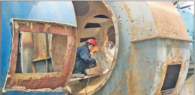
工人在检修锅炉引风机。 本报记者 张帅 摄
