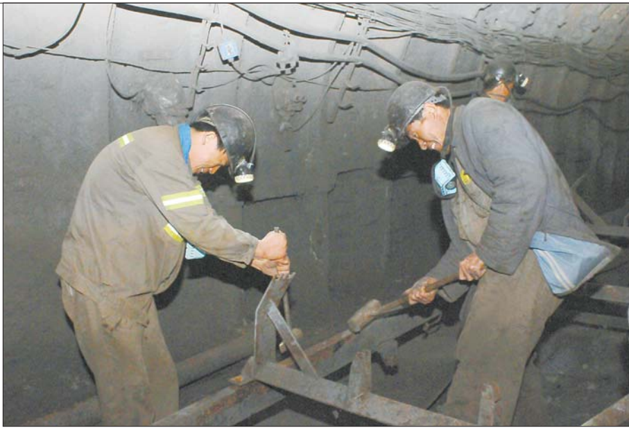
皮带工区的员工在海域皮带副巷对皮带架进行拆卸。(资料片)
