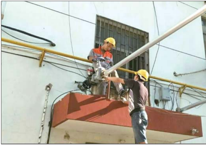
供暖管理员正在维护改造供暖管线。(资料图)
