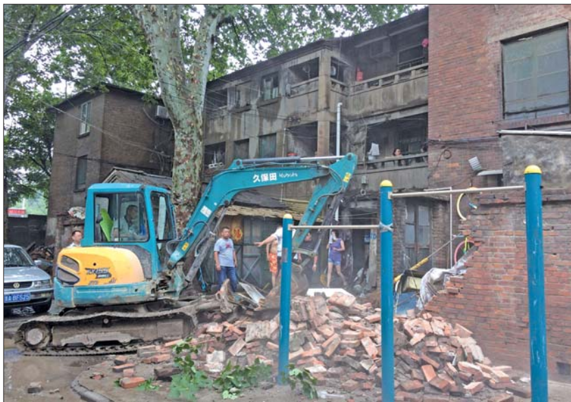
19日,国棉三厂五宿舍简易楼下违建开拆。
