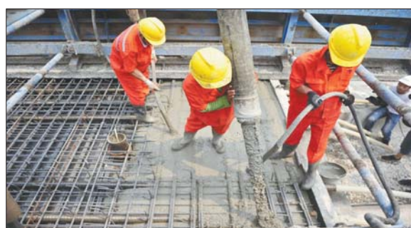
2017年6月20日,中铁十四局济南轨道交通R1线U梁场内,正在进行最后一片U梁浇筑,标志着R1线966片U梁预制全部完成。
