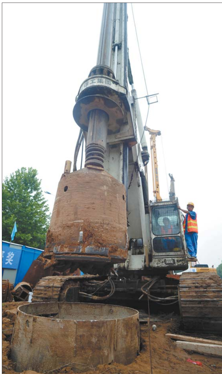
2015年7月16日,前大彦站钻第一个桩基孔,标志着R1线正式开工。
