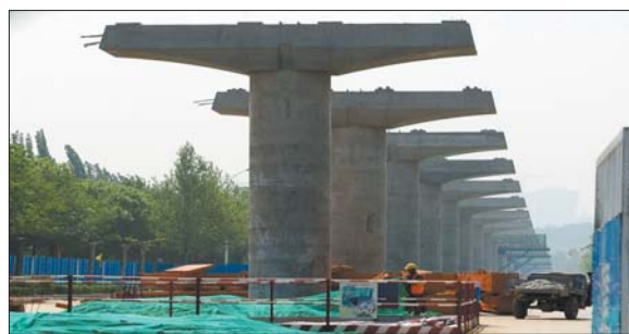
2016年4月21日,济南地铁R1线海棠路园博园站到大学城站区间段的高架桥墩成列。本报记者 周青先 摄
