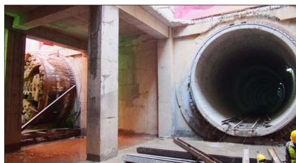
2017年3月9日,济南西站至演马庄西站区间左线盾构机“前进二号”顺利出洞实现双线贯通。本报记者 周青先 摄
