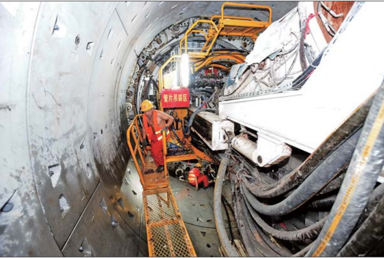
2016年8月31日,地铁R1线地下,工人冒着酷暑闷热在工作。 本报记者 周青先 摄
