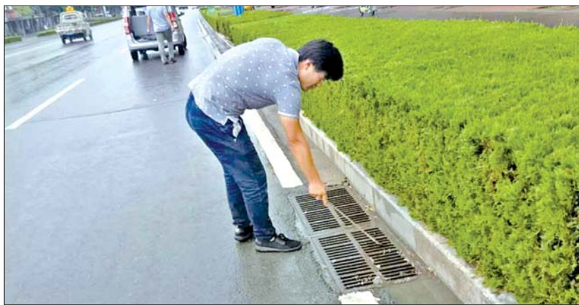
工作人员清理排水设施中的杂物。
