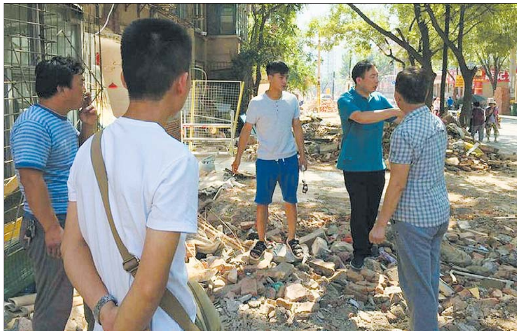
铁一社区拆违现场的志愿者。
