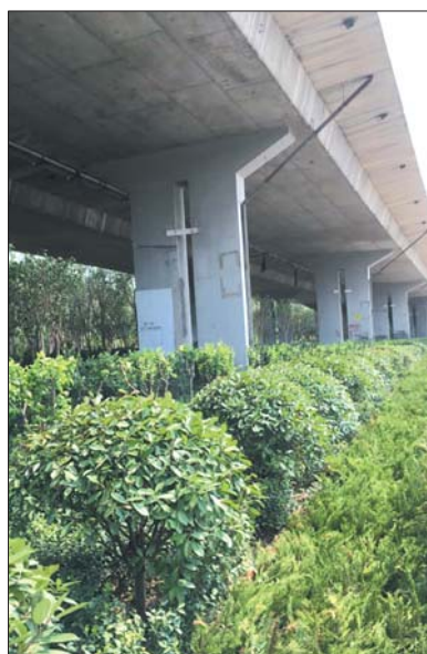
二环北路的违建被拆除后种上了绿植。本报记者 蒋龙龙 摄
