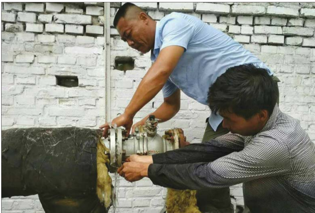
施工人员正在清理管道滤网。 实习生 张素素 摄
