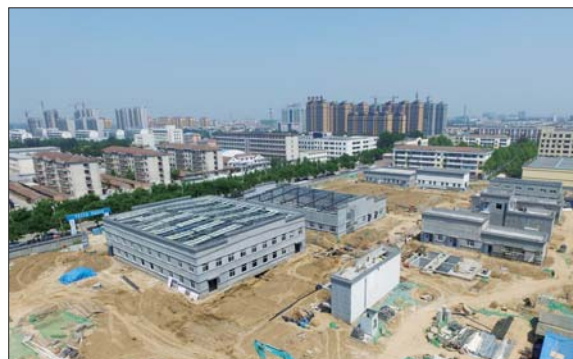
投资近5000万元,日供水能力3万吨的新水厂,将实现水质优于国标,生产自动化、制水无人值守。
