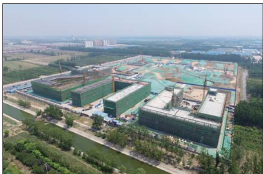
职业中专是全市第一个使用装备式建筑的学校。
