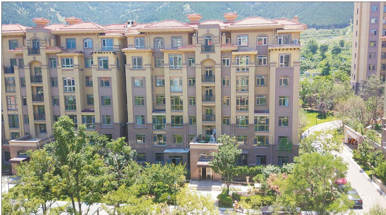
漫山香墅的楼顶原本都有露台,大多数顶楼业主都将其封闭起来,成了违建。 本报记者 刘雅菲 摄
