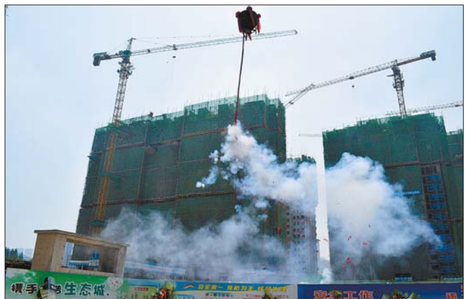
丁家村安置房部分封顶。 本报记者 刘飞跃 摄
