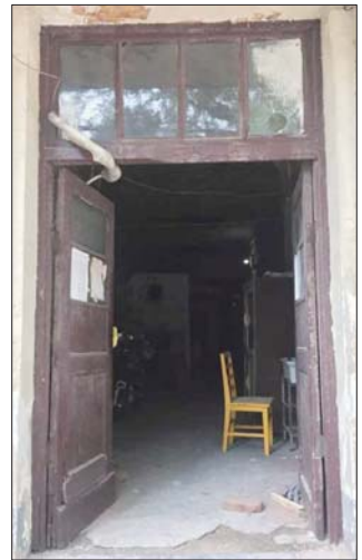
一楼走廊里堆着杂物。
