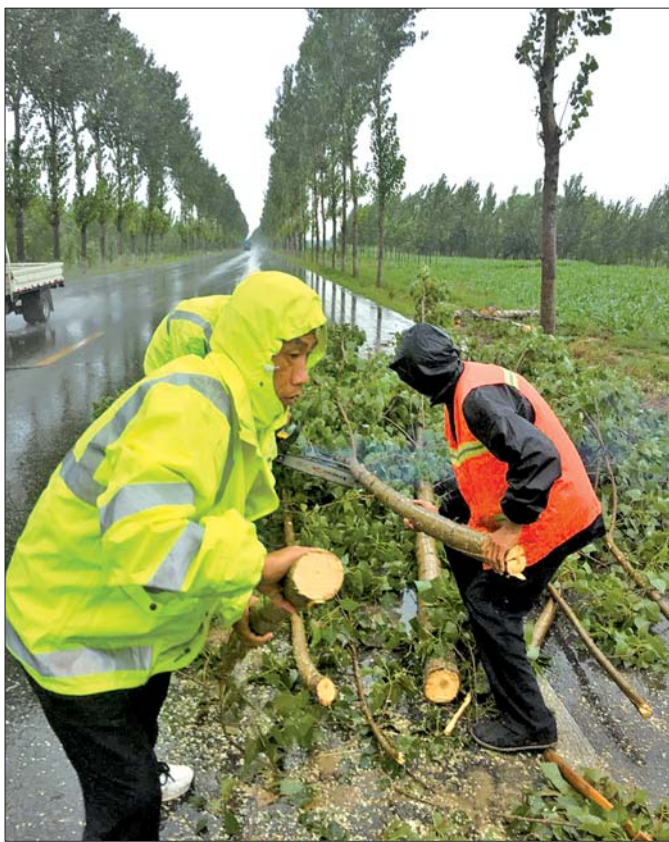
公路站工作人员冒雨清理道路树木。
