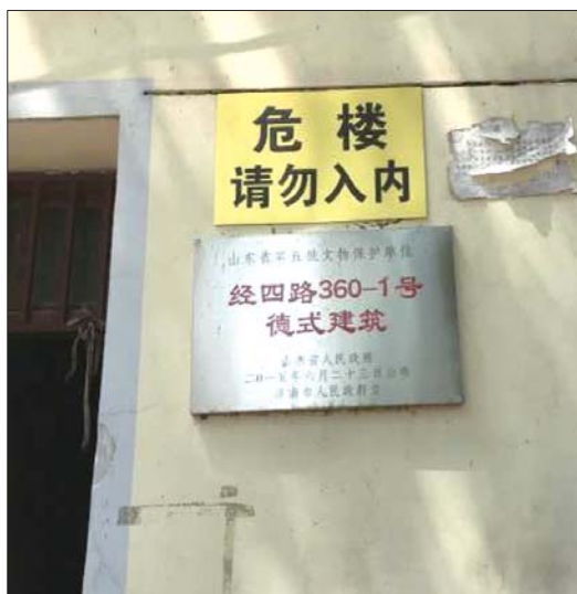
◀德式建筑楼上同时挂着文保铭牌和危楼警示牌。
