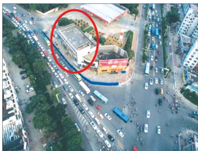
圆圈部分已拆除。
