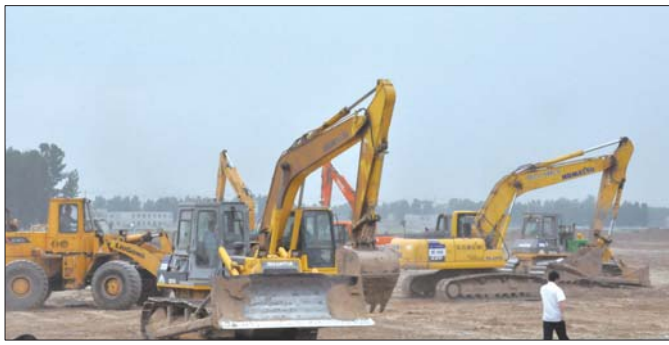
东明县焦园乡8号村台建设工地现场。(资料图) 本报记者 李德领 摄
